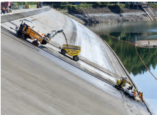
Bild 7.6: Bauarbeiten am Damm der Biggetalsperre Fig. 7.6: Construction at the Bigge Reservoir's dam
