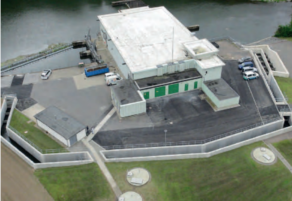
Bild 17.5: Fischeaufstiegsanlage am „Bunker“ Villigst Fig. 17.5: Fish migration facility at the Villigst “bunker”
