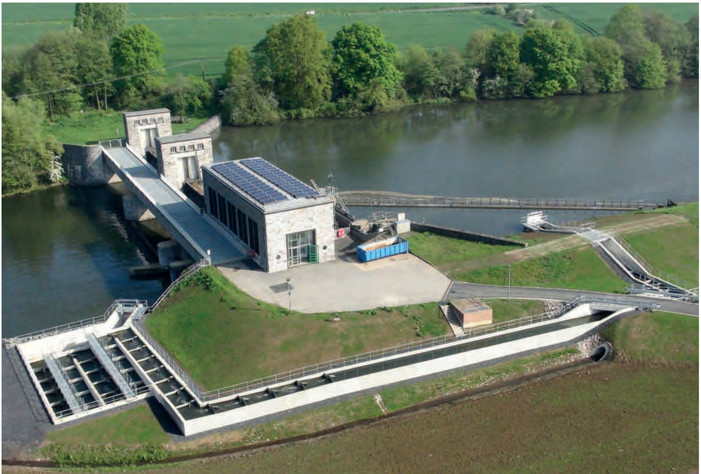
Bild 17.1: Die Wasserwerke Westfalen GmbH hat alle Wasserkraftanlagen umweltorientiert mit Fischaufstiegen aufgerüstet (hier WKA Echthausen). Die ökologische Durchgängigkeit an der Ruhr ist somit auf den 60 Flusskilometern, an denen WWW Wasserwerke und Stauanlagen betreibt, gegeben.
