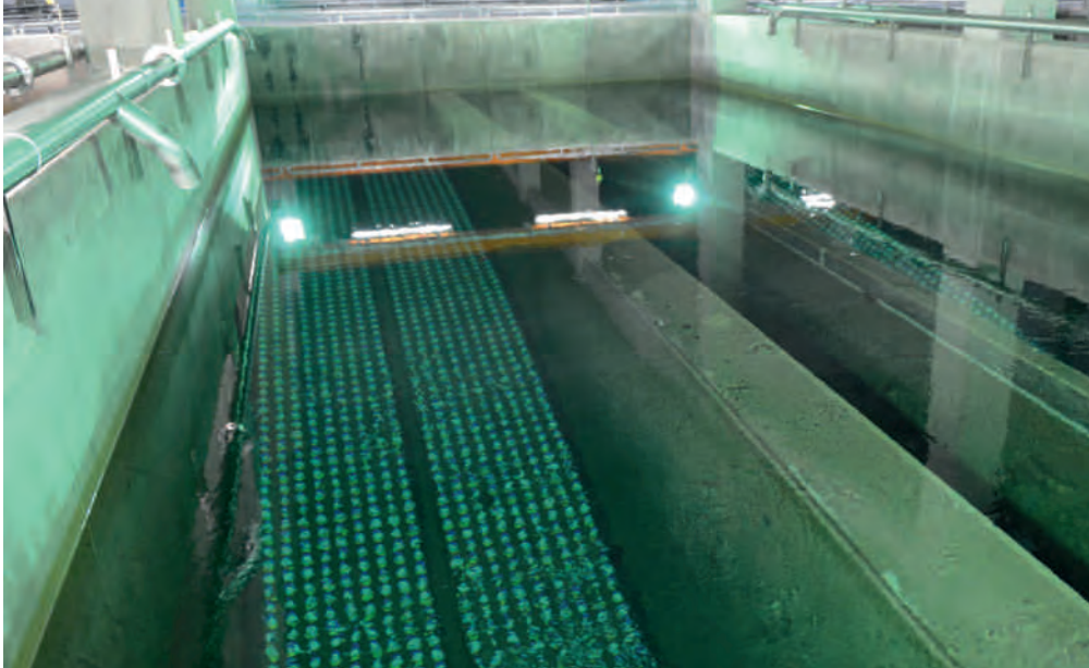
Bild 16.3: Einer der Adsorptionsfilter – noch ohne Aktivkohleschüttung – während der hydraulischen Inbetriebnahmephase
