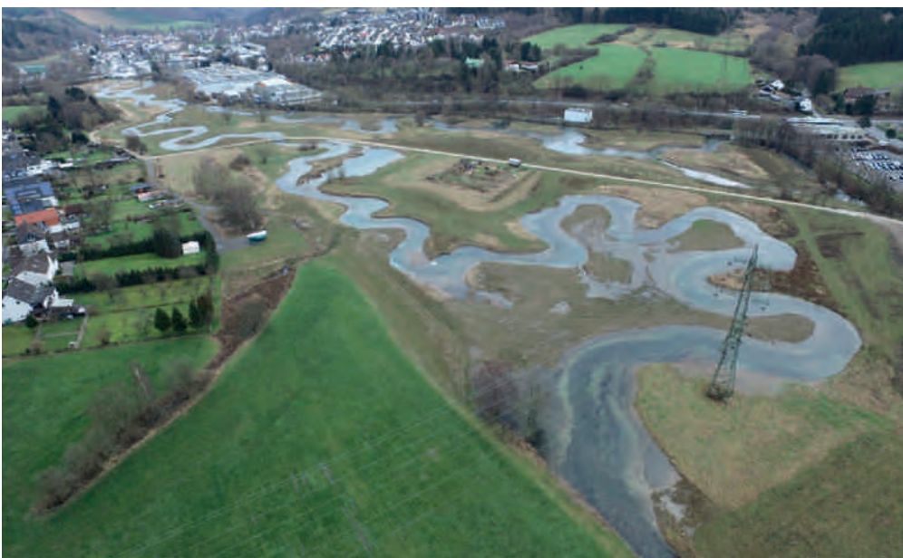
Bild 6.11: Frisch renaturierte Sorpe bei Sundern-Hachen, unterhalb der Sorpetalsperre Fig. 6.11: Recently renaturated Sorpe river at Sundern-Hachen, downstream of the Sorpe Reservoir
