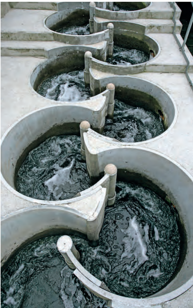
Bild 17.4: Mäander-Fischpass am Standort Fröndenberg (Fertigstellung 2001)
