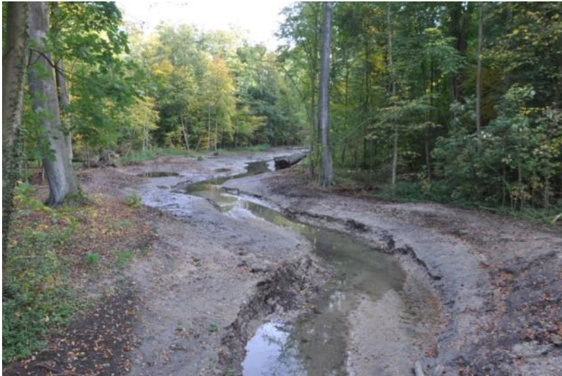
Bungtbach während Bauphase
