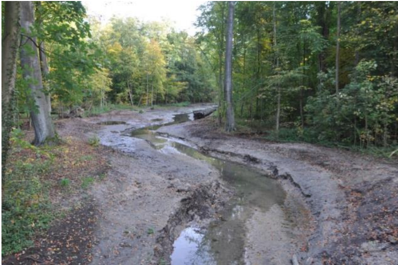
Bungtbach während Bauphase
