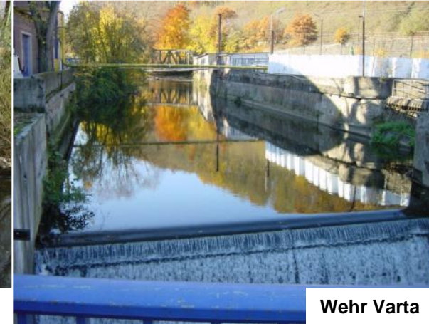
ehem. Wehr Varta
