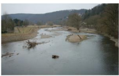
Dokumentation einer Renaturierungsmaßnahme an der Ruhr bei Arnsberg, die in Art und Umfang mit der dargestellten Planung vergleichbar ist. Auf der linken Abbildung aus dem Oktober des Jahres 2010 ist das Gelände vor Beginn der Einbauten dargestellt. Der Ruhlauf beschränkt sich auf ein strukturares, gleichförmiges Gewässerbett mit befestigten Ufern.
