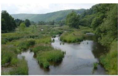
Die Aufnahme aus dem März 2012 zeigt, wie der Ruhlauf auf das 3-4 fache der ursprünglichen Breite aufgeweitet wurde. Ehemalige Uferfragmente mit Alghölzen strukturierten das breite und flache Gewässerbett, das bei normalen Abflussverhältnissen von weiten, umlagerungsfähigen Kiesflächen geprägt wird.
