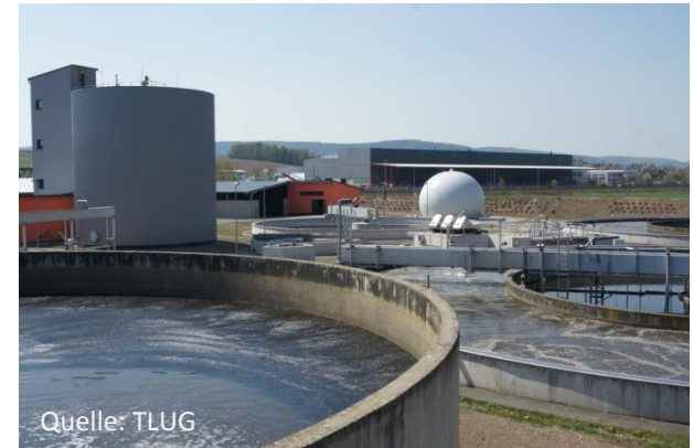
Nährstoffreduzierung durch Abwassermaßnahmen
