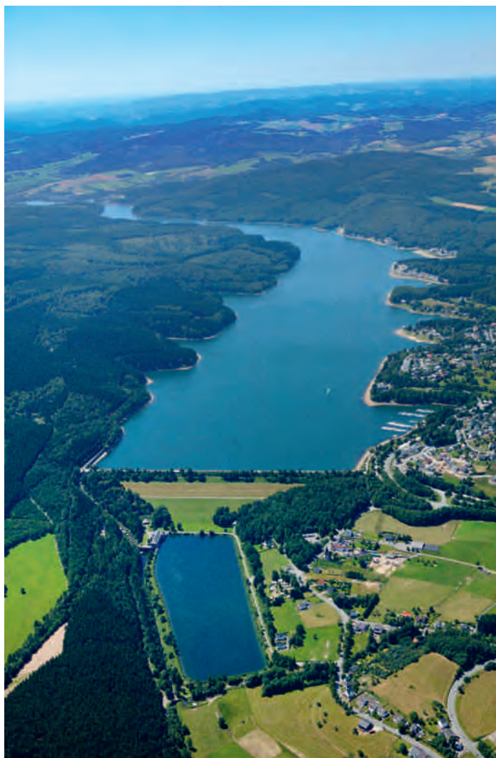
Bild 5.3: Luftaufnahme der Sorpetalsperre Fig. 4.3: Aerial view picture of the Sorpe Reservoir
