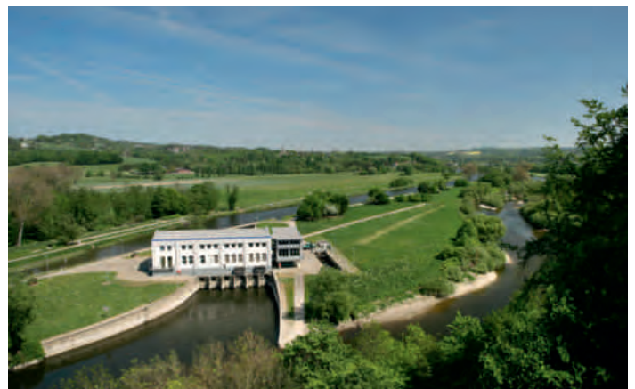
Bild 18.5: Wasserwerk und Wasserkraftanlage Bochum-Stiepel Fig. 18.5: Waterworks and hydropower plant Bochum-Stiepel
