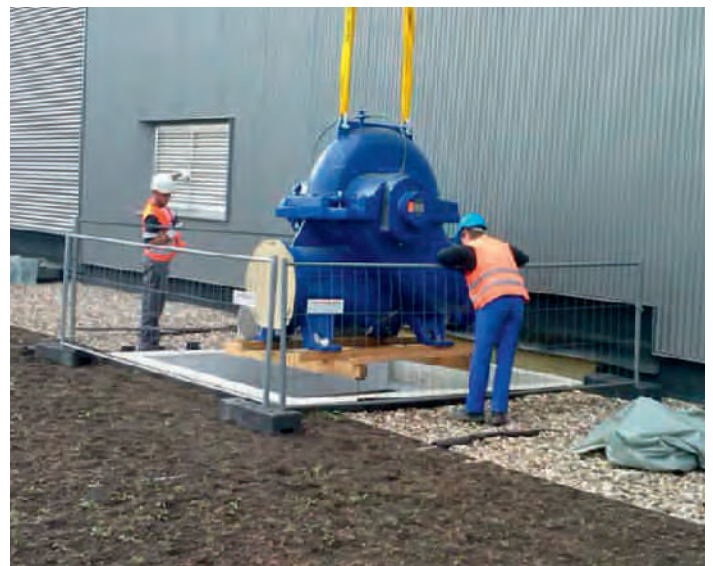
Bild 18.2: Einbringung einer der drei Rohwasserpumpen am Standort Horst Fig. 18.2: Installation of one of the three raw water pumps at the Horst site
