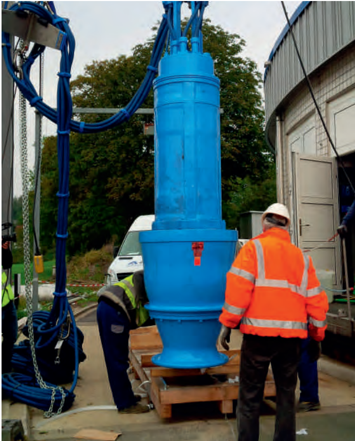
Bild 18.1: Kontrolle des statischen Mixers zur Einmischung von Wasserstoffperoxid zur Restozonvernichtung in der Wasseraufbereitungsanlage I in Überraehr Fig. 18.1: Checking the static mixer for the blending of hydrogen peroxide to eliminate residual ozone at the water treatment facility I at Überraehr
