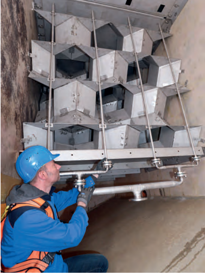
Bild 18.3: Einbringung einer der sechs Schnellfiltratpumpen in den Rohrkeller der Wasseraufbereitungsanlage II in Überruhr Fig. 18.3: Installation of one of the six rapid filtration pumps in the pipe gallery at the water treatment facility II at Überruhr
