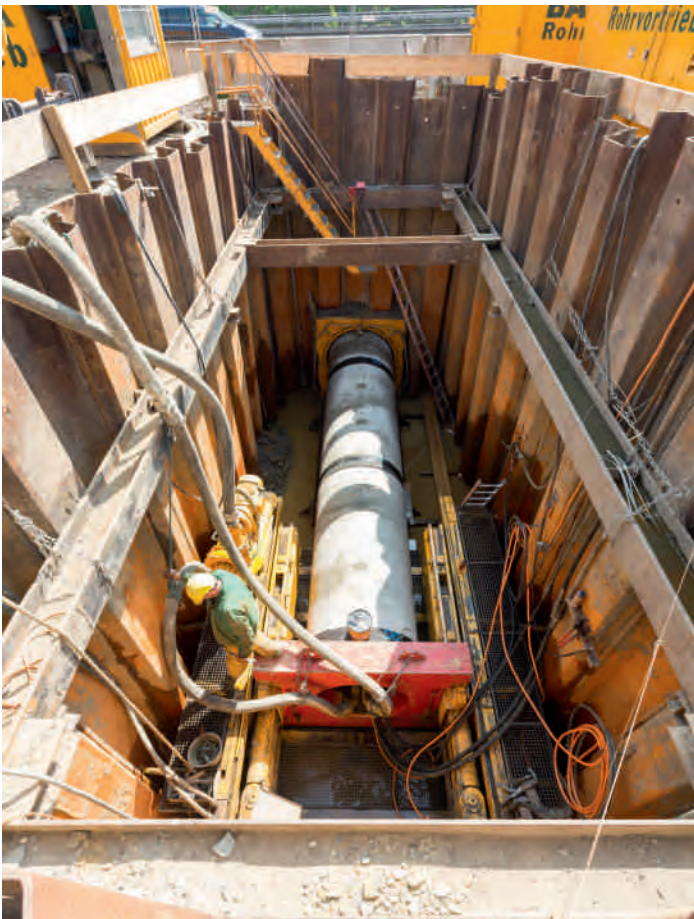
Bild 18.6: Unterpressung der Autobahn A 43 Fig. 18.6: Pipe ramming underneath the A43 motorway
