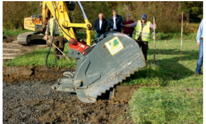
Bild 17.6: Absetzen der Grassoden Fig. 17.6: Placing of the sods
