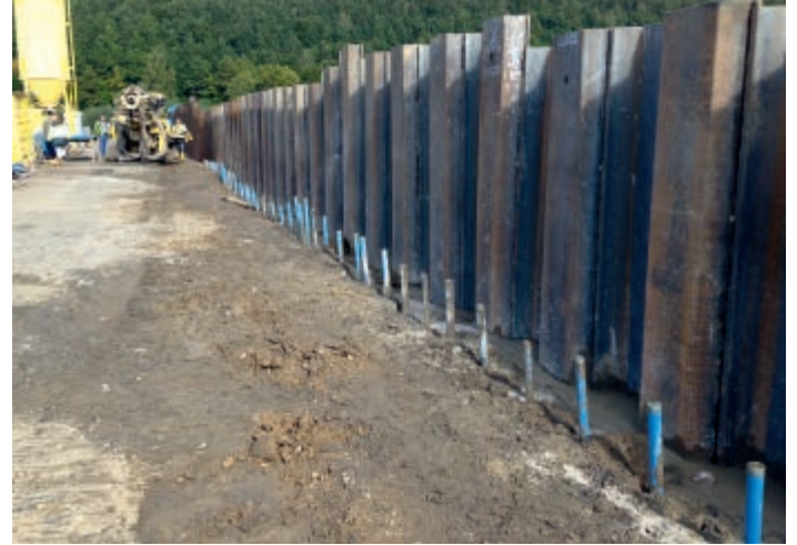
Bild 17.10: Verpressen der Spundwand Fig. 17.10: Crimping of the sheet pile wall
