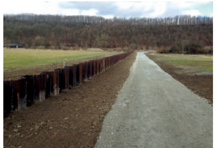
Bild 17.11: fertiggestellte Spundwand Fig. 17.11: Completed sheet pile wall
