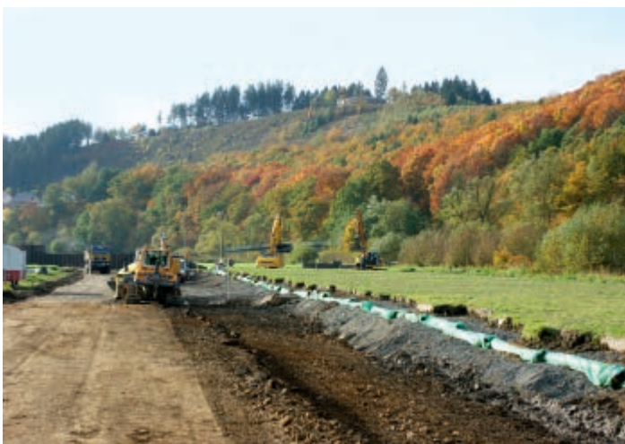
Bild 17.12: Bau des Deichkörpers Fig. 17.12: Construction of the body of the dyke
