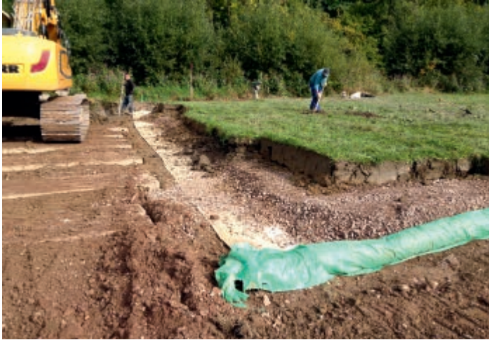
Bild 17.7: Herstellen der Vorlandabdichtung Fig. 17.7: Production of the sealing
