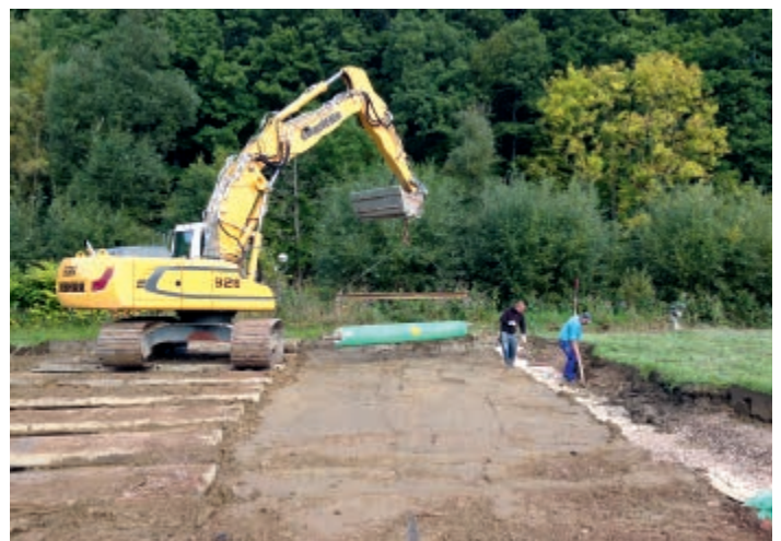
Bild 17.13: Verlegen der Bentonitbahnen Fig. 17.13: Installation of the bentonite layer
