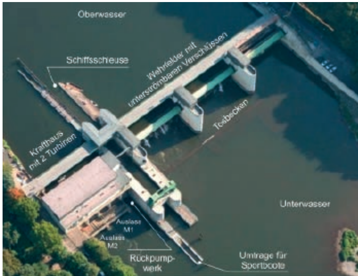
Bild 9.1: Querbauwerk Baldeney mit Kraftwerk, Schleuse und Wehranlage Fig. 9.1: The Baldeney barrier with power plant, floodgate and weir
