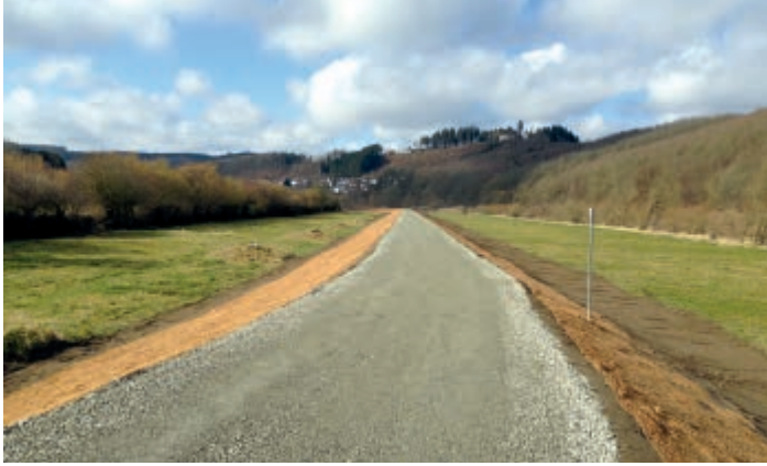
Bild 17.4: Fertiggestellter Deich Fig. 17.4: Completed dyke
