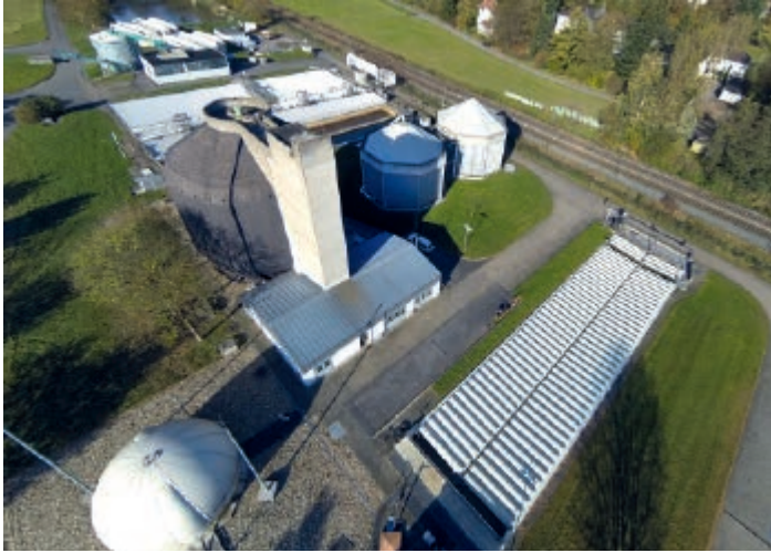
Bild 7.1: Luftbild der Kläranlage Warstein Fig. 7.1: Aerial view of the Warstein sewage treatment plant
