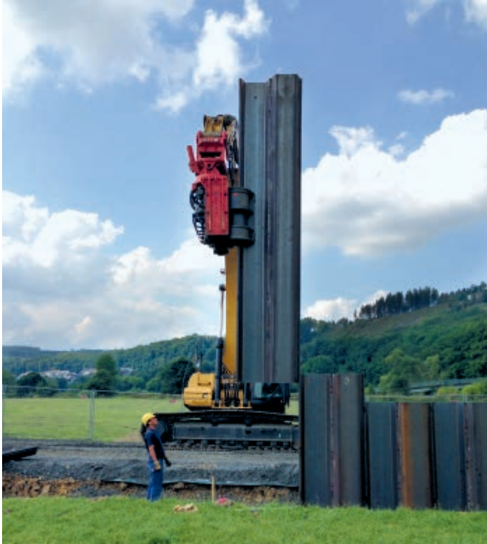
Bild 17.9: Rammen der Spundwand Fig. 17.9: Ramming of the sheet pile wall
