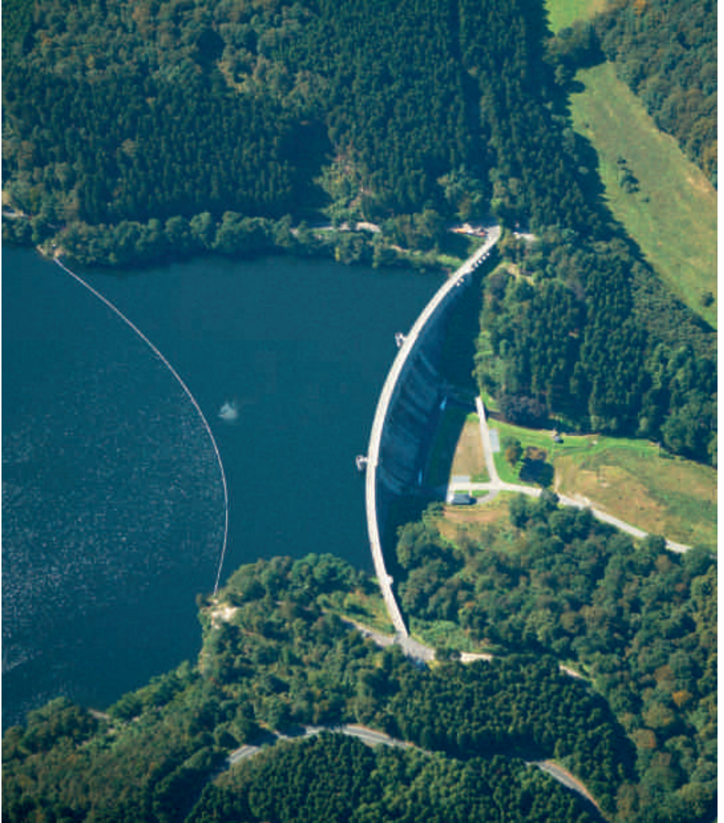
Bild 4.2: Luftaufnahme der Ennepetalsperre Fig. 4.2: Aerial photograph of the Ennepe Reservoir
