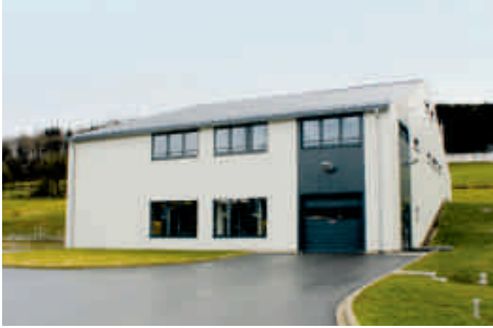
Bild 16.2: Gebäude der neuen Aufbereitungsanlage Fig. 16.2: Building of the new treatment plant
