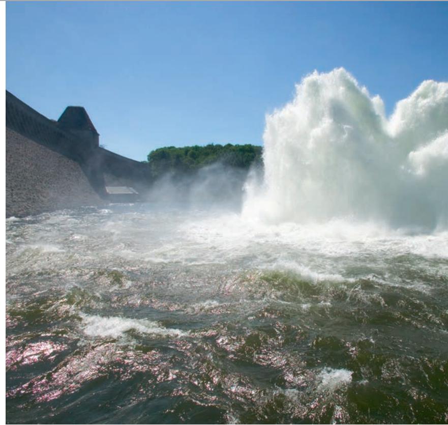
Die Funktionsfähigkeit der Grundablässe wird überprüft.
