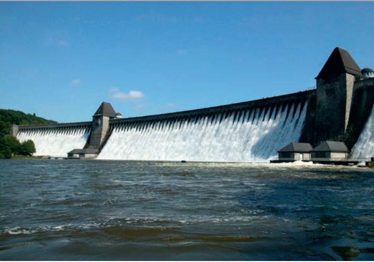
Die mächtige Bruchsteinmauer bietet bei Hochwasserüberlauf einen imposanten Anblick.
