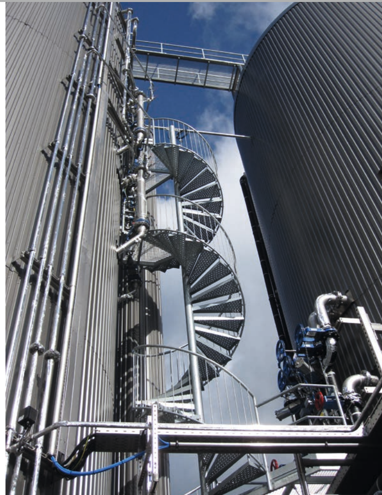
Treppenturm der Anaerobanlage
