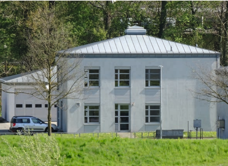
Betriebsgebäude und Wagenhalle
