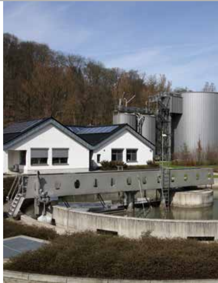
Betriebsgebäude mit Photovoltaikanlage
