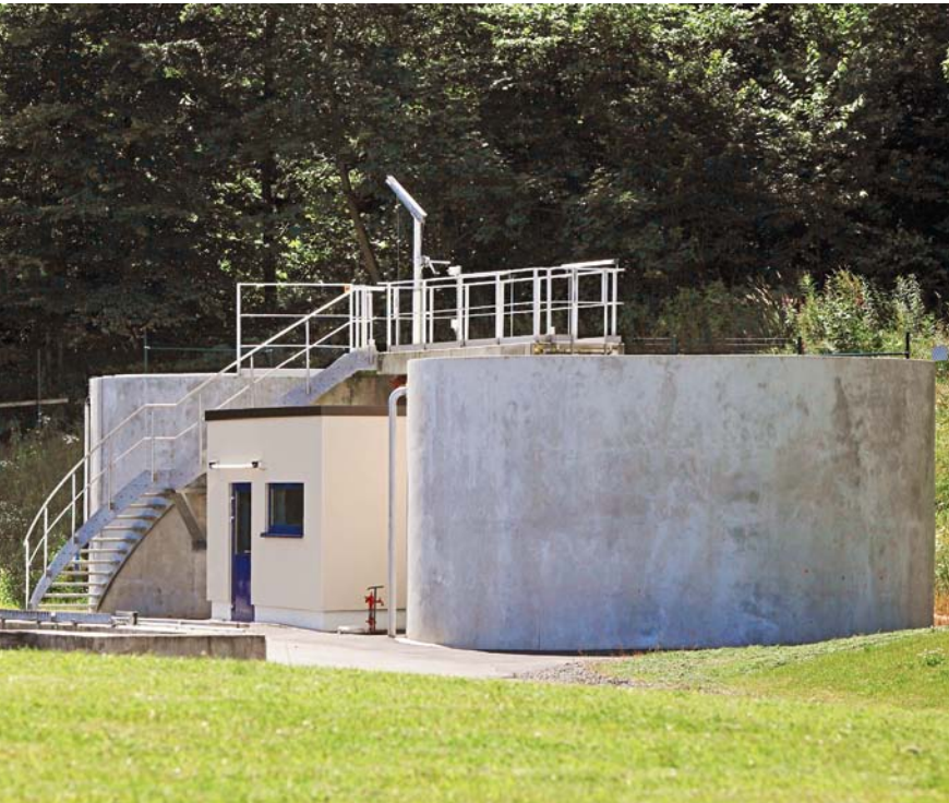
Schlammstapelbehälter und Trübwasserspeicher
