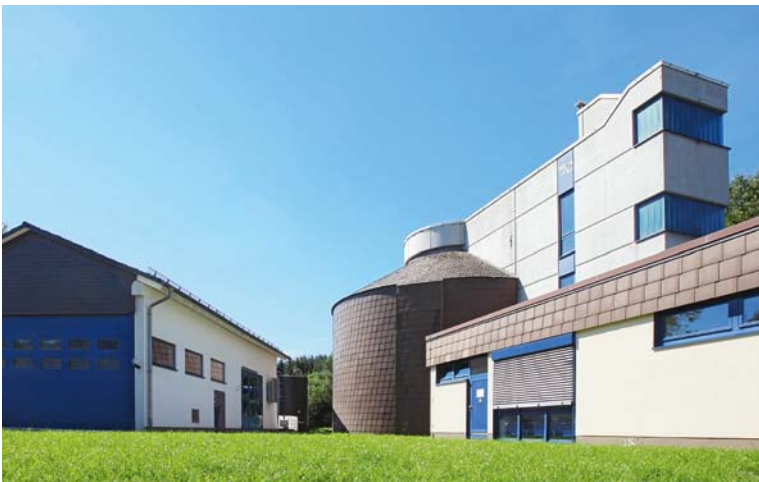
Faulbehälter und Schlammentwässerungsgebäude
