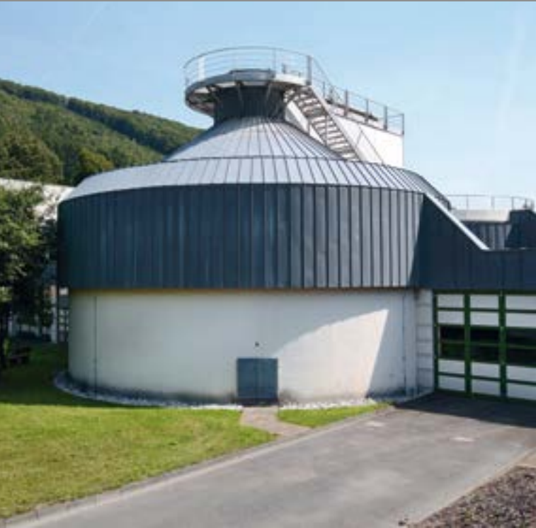
Der überschüssige Schlamm wird im Faulbehälter ausgefault.
