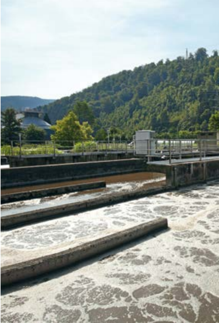
Belebungsbecken der Kläranlage Plethenberg.
