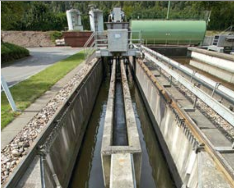
Die Fließgeschwindigkeit reduziert sich im Sandfang ...
