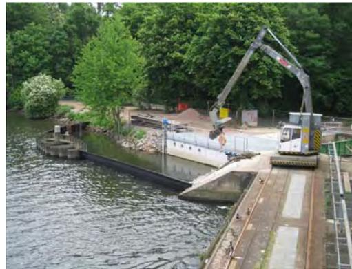
Die Montage einer Tauchwand im Oberwasser soll das Einspülen von Treibzeug in die Anlage verhindern. Diese ist so montiert, dass die Hauptfließströmung um die Ausstiegsstelle herumgeleitet wird.
