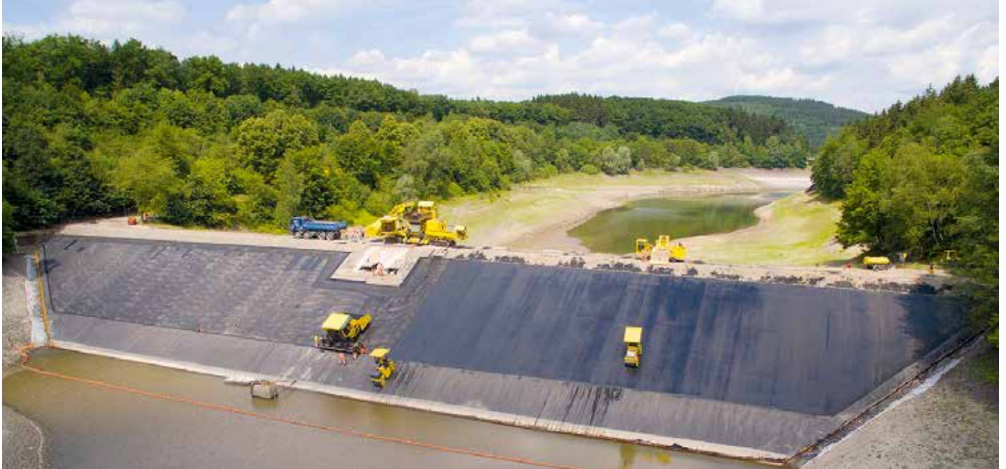
Bild 18: Dichtungseinbau Vorsperre Kessenhammer Fig. 18: Placing the asphalt sealing of the Kessenhammer preliminary dam
