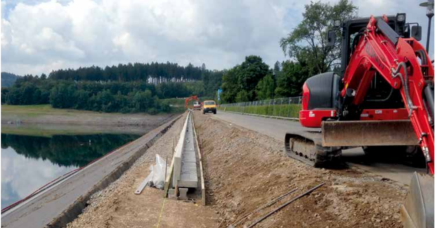
Bild 20: Kronenanschluss im Bau (Betonfertigteile) Fig. 20: Dam shoulder under construction (precast concrete units)
