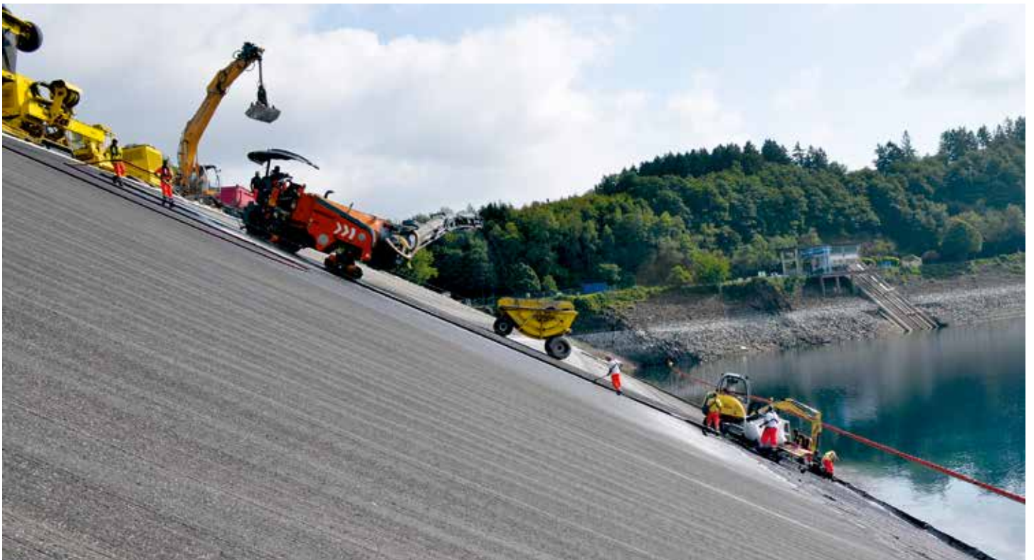
Bild 21: Fräsarbeiten Hauptdamm Fig. 21: Milling work at the Bigge dam
