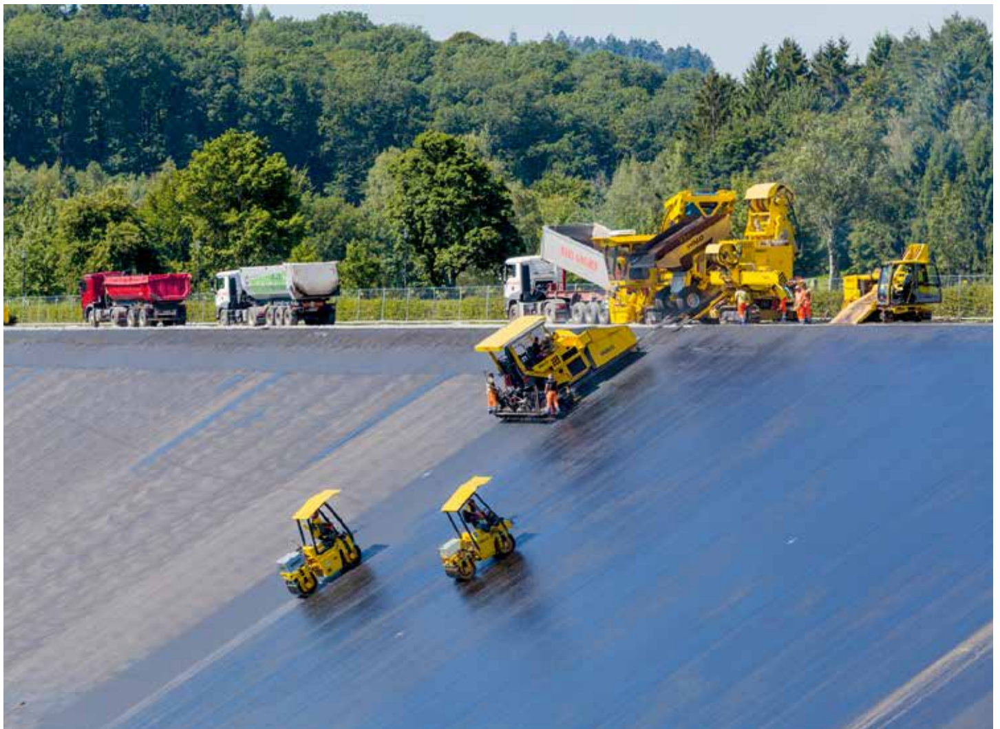
Bild 22: Dichtungseinbau am Hauptdamm Fig. 22: Placing the asphalt sealing at the Bigge dam
