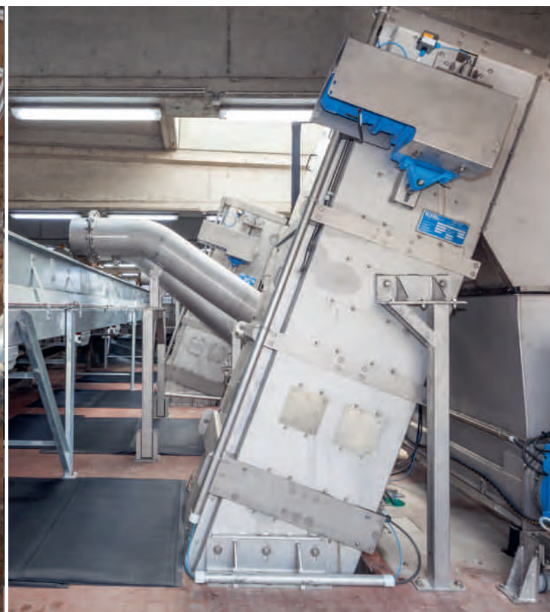
Über eine neue Druckrohrleitung, die an die bestehende Leitung angeschlossen wurde, wird nun das Abwasser aus Witten-Herbode zur Kläranlage Bochum-Ölbachtal gepumpt (l.). Auf der Kläranlage Duisburg-Kaßlerfeld wurden die Rechen, die Rechengutpressen und die nachgeschaltete Fördertechnik erneuert (r.).
