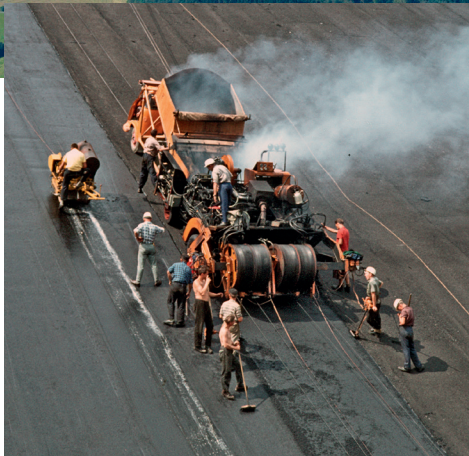
Der Hauptdamm der Biggetalsperre (großes Bild) hat eine Dichtung aus Asphaltbeton. Sie wurde beim Bau der Talsperre in den 1960er-Jahren aufgetragen (kleines Bild) und muss jetzt erneuert werden.
